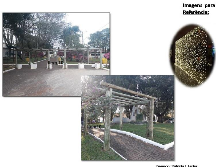
Figura 6: Instalações do item 10 nos Pergolados da Praça Municipal.
